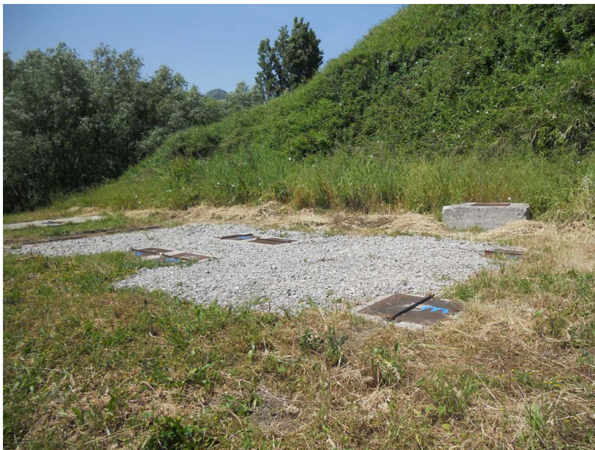
Figura 3.2 - Veduta di una parte dell'impianto di trattamento esistente.
